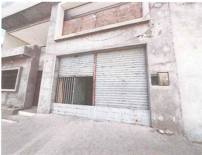
Imagem 2: Fachada do Prédio Vistoriado.
